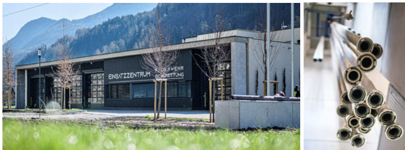
Die neue Einsatzzentrale mit dem zwölf Meter hohen Schlauch- und Übungsturm.
